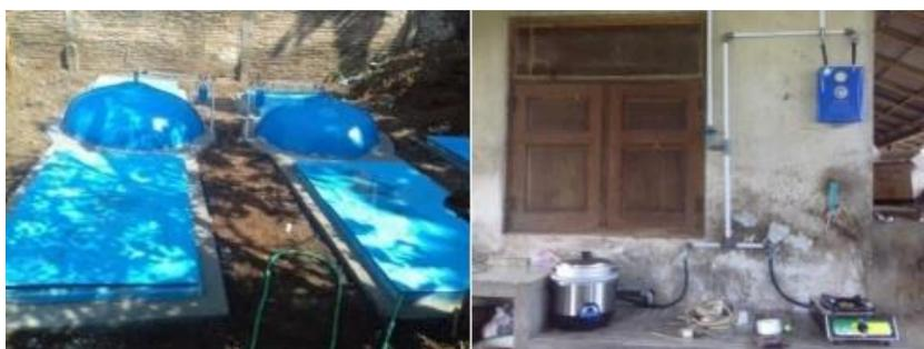
Gambar 24. Pemasangan biogas dan biourine serta instalasi energi listrik
